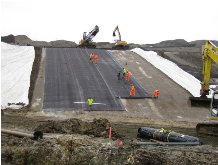
Abb. 6: Deponiebaumaßnahme mit Auflager, Drainage- und Bentonitmatten
