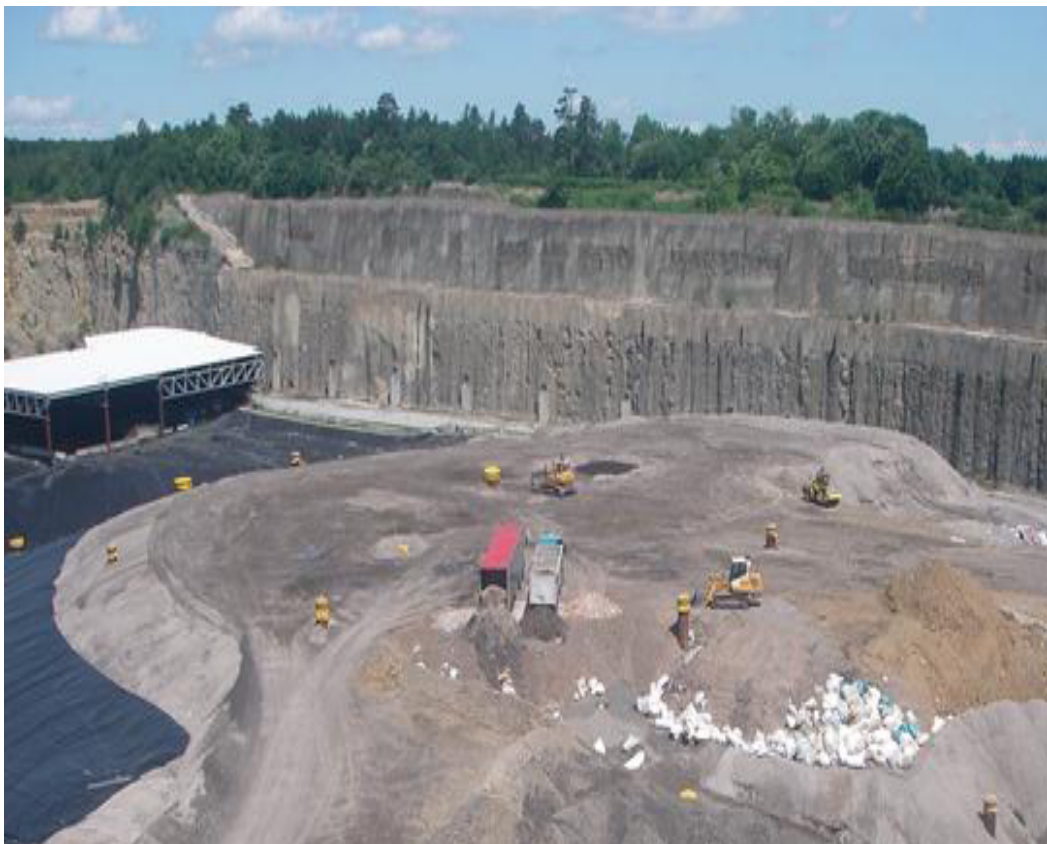
Abb. 1: Abfalleinbau auf einer Deponie
